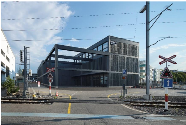
Depuis 2018, la nouvelle construction est située directement à côté de la gare de Lenzbourg (architecture : pool Architekten, Zurich)
